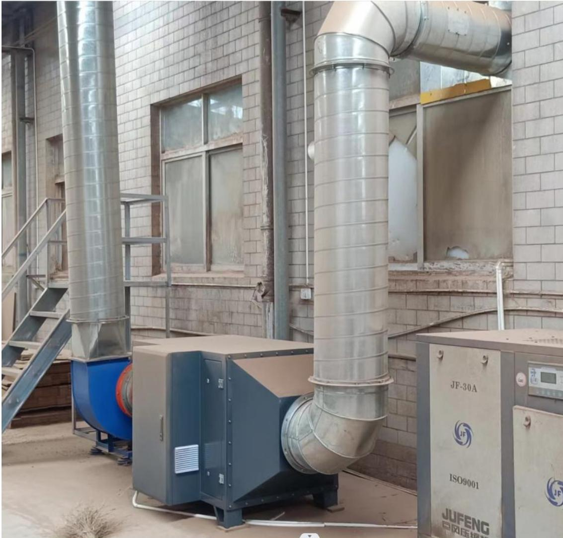
图 3-2 UV 光解+活性炭吸附装置废气处理设施
