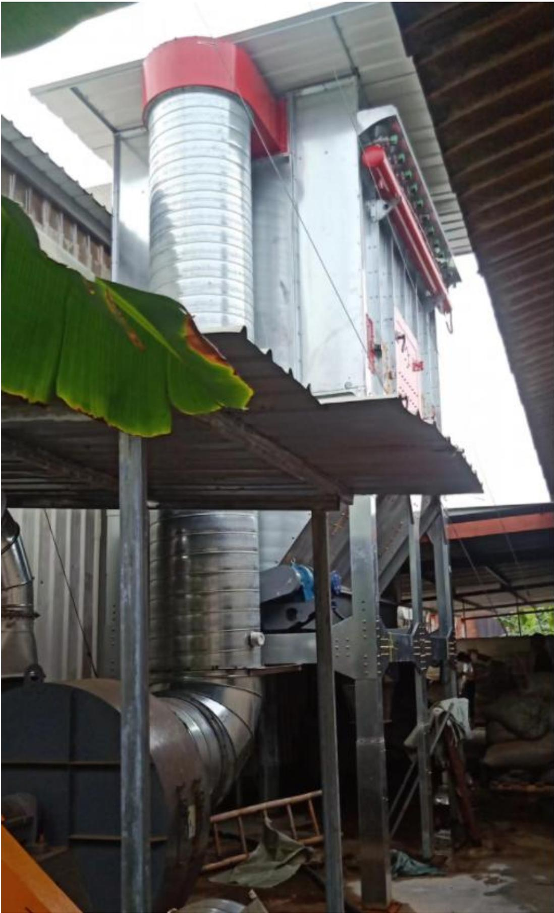
图 3-1 布袋除尘器废气处理设施
