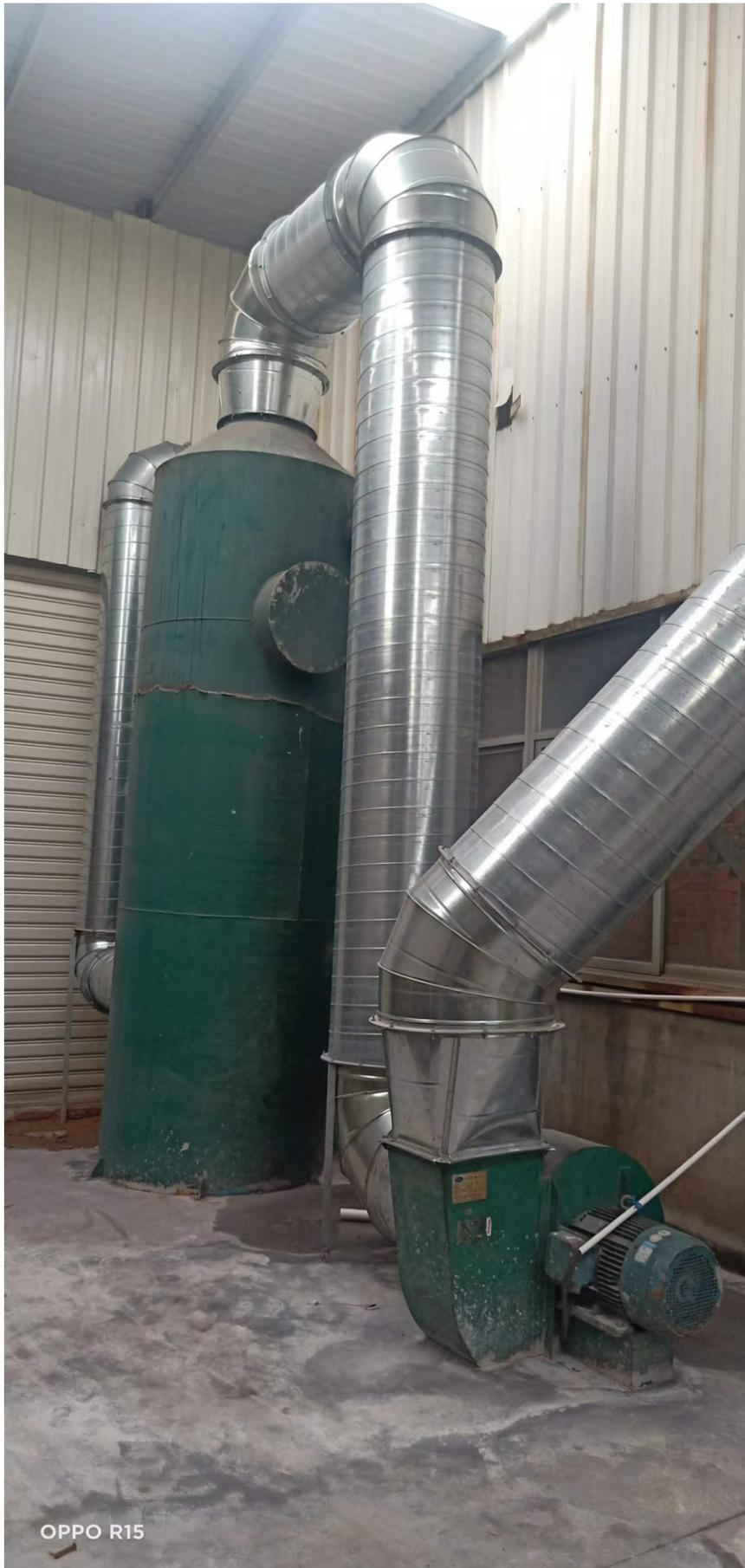
图 3-1 压铸废气处理设施
