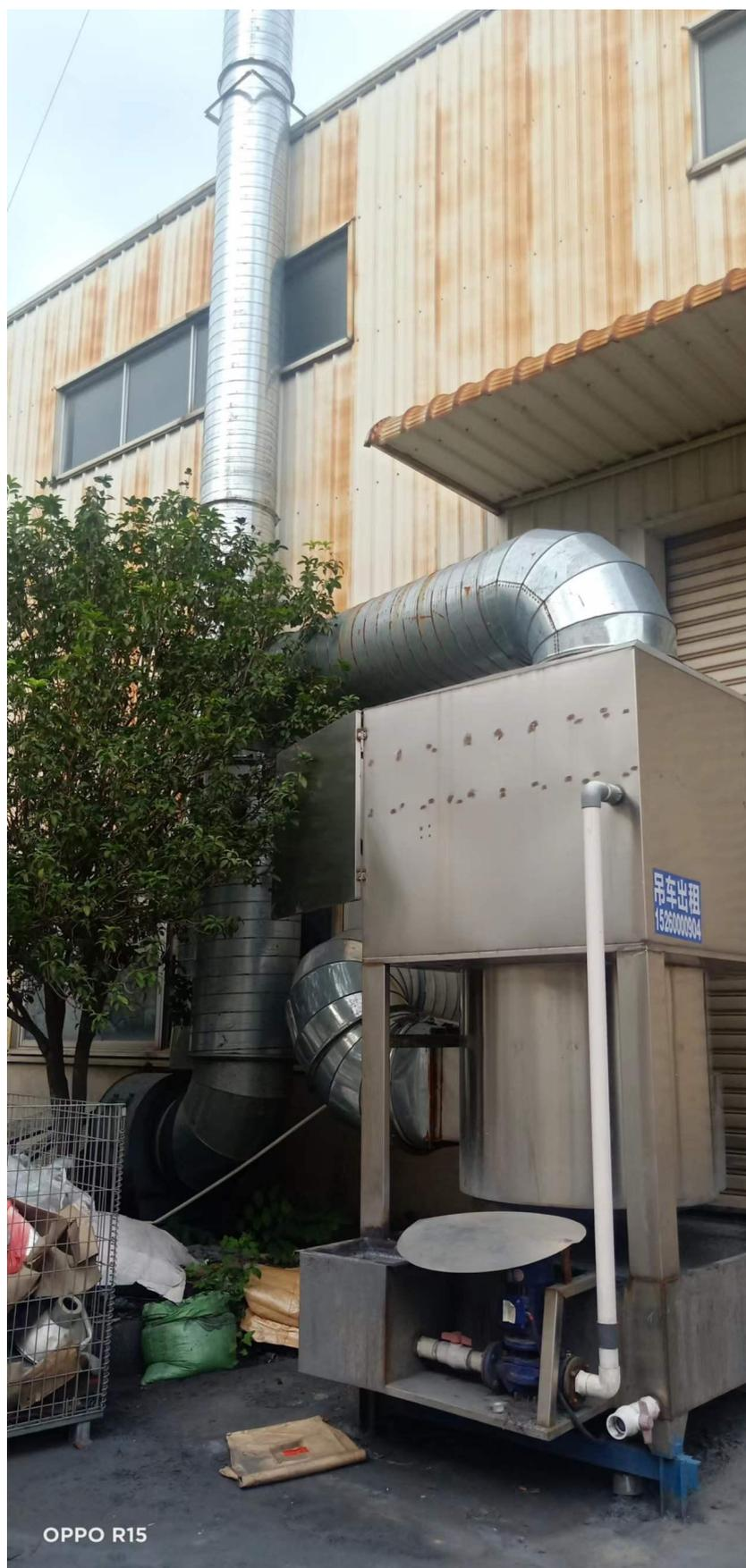
图 3-2 抛光及抛丸工序废气处理设施
