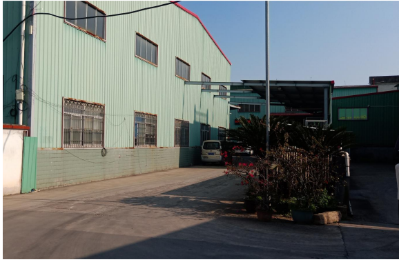
东面现状图（仓库）
