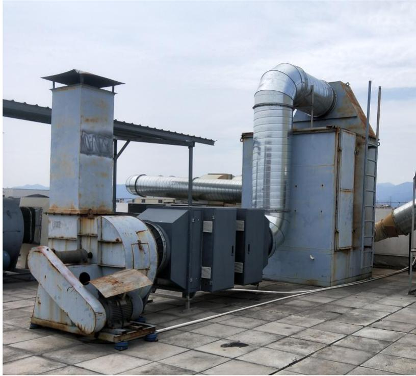
图 3-1 有机废气-UV 光解+活性炭吸附装置+排气筒
