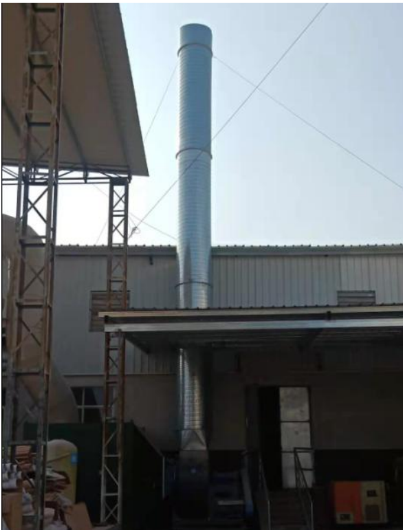
旋流板洗涤塔+经活性炭吸附装置+15m 高排气筒排放
