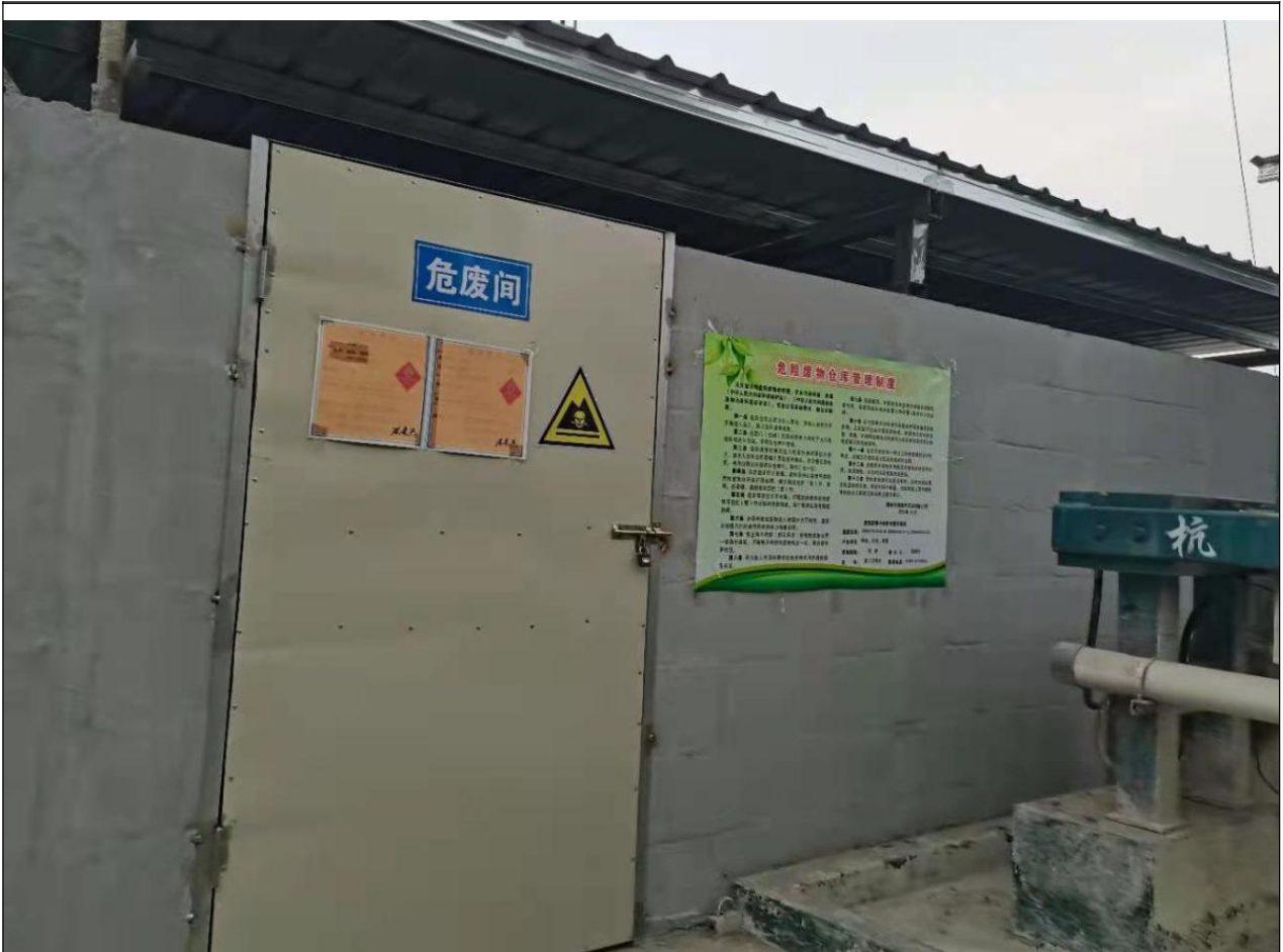
危险废物暂存间
