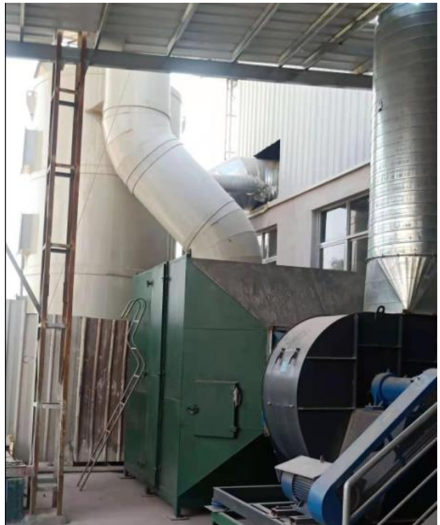
旋流板洗涤塔+经活性炭吸附装置+15m 高排气筒排放
