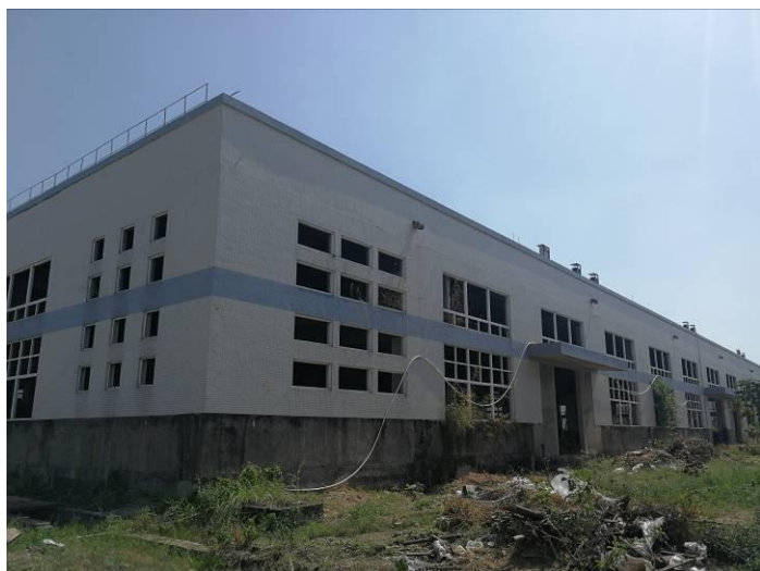
北侧现状图（空置厂房）
