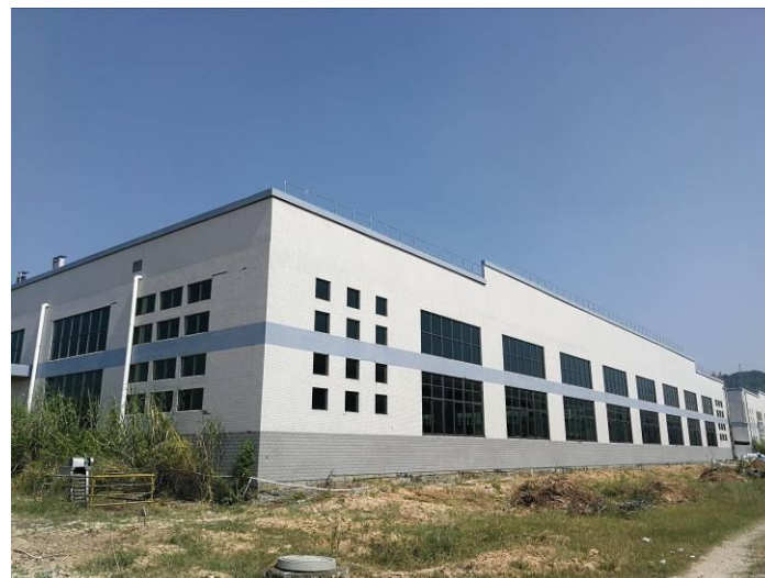
西侧现状图（盈丰食品股份有限公司仓库）
